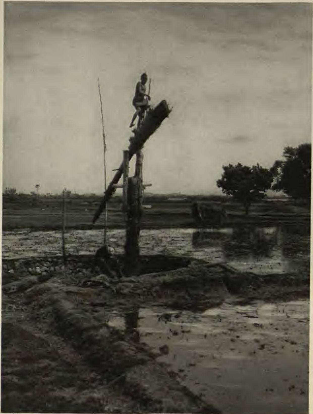
Bewässerungsanlage bei Chingleput Dispositif pour l'irrigation pres de Chingleput
